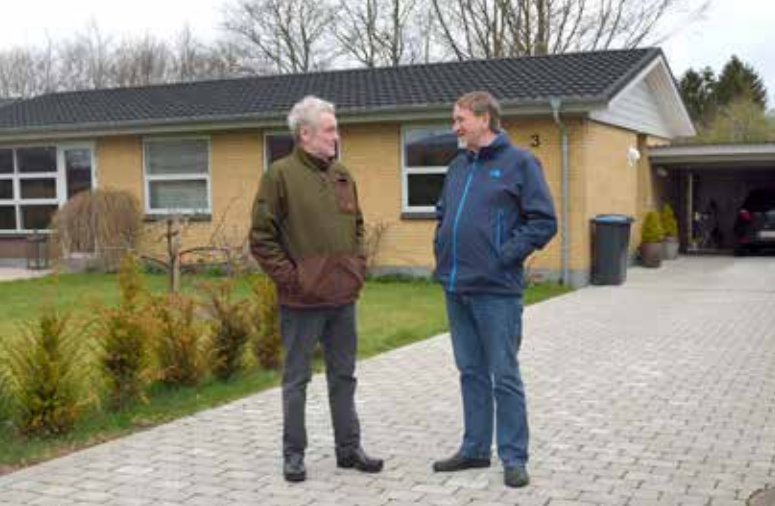
Afdelingsformand Jørgen Kjeldsen og driftschef Lars Larsen i én af de nye indkørsler. Afdelingen har de seneste år fået lagt nye tage, er blevet isoleret bedre og har fået nye døre og vinduer. Nu lægges der nye indkørsler.
