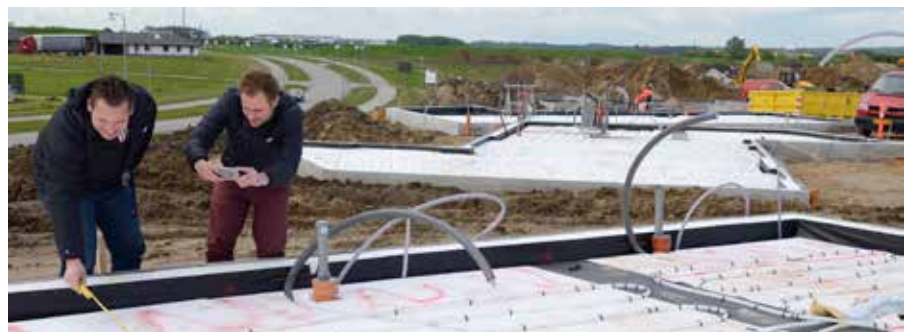
Gulvvarmen er lagt i endnu et hus, og projektchef Morten Langhoff-Jensen (til højre) og praktikant Mads Skyt-Petersen, CASA, kontrollerer, at alt er i orden. CASA har totalentreprisen, Laban Arkitekter i Silkeborg har tegnet, og Constructa, Silkeborg, er ingeniører på opgaven.
